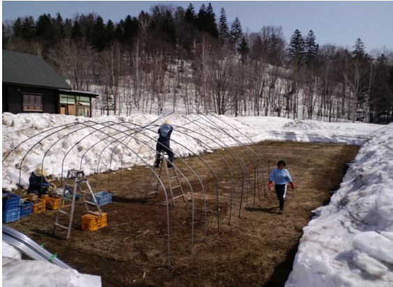
苗立てハウス組み立て中
